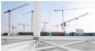
Alexander Obst/Martin Schmitling Blick auf das Hauptgebäude vom Dach der Technik- und Logistikzentrale
